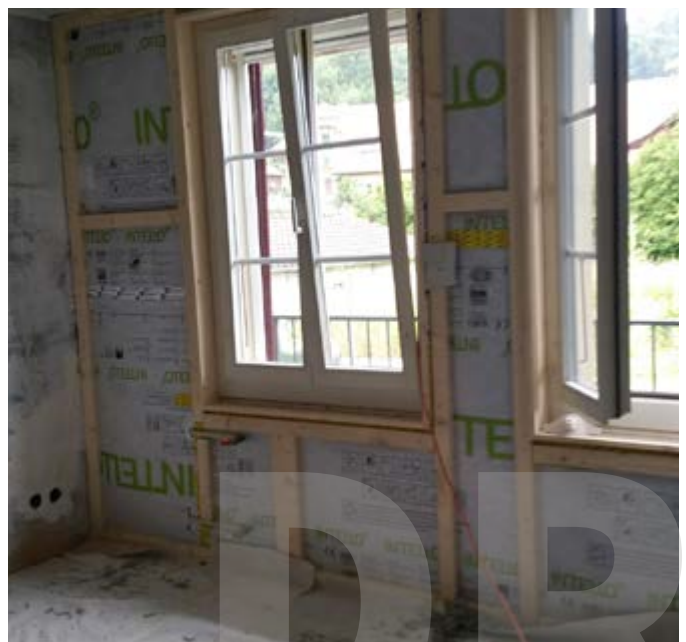
Abbildung 3: Zellulose-Einblasdämmung auf der Innenseite der Wand (Foto: Auraplan)
